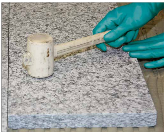
3 Marteler la dalle de pierre naturelle...
