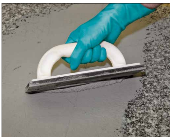
5 Jointoiment du revêtement en pierre naturelle avec p. ex. le Joint Déco Flex Sopro DF® 10.
