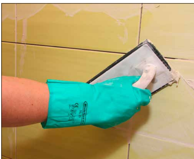
9 Application du Joint Sopro DF 10® sur les carreaux de faïence.
