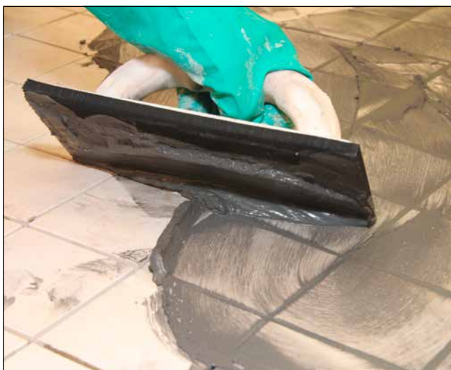
7 Application du Joint Sopro DF 10® sur les carreaux de grès pleinement vitrifiés.
