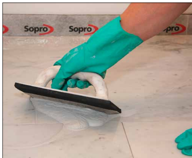
8 Application du Joint Sopro DF 10® sur les pierres naturelles sensibles aux décolorations.
